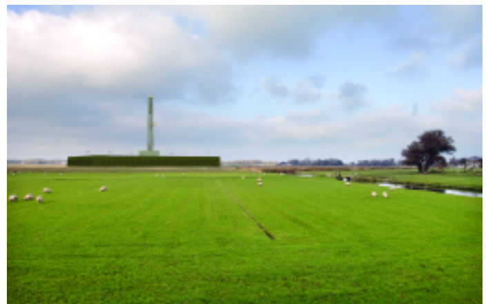
De situatie op de Bergermeer locatie tijdens het boren
